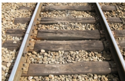
Rails courts sur traverses bois
