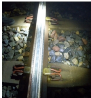
rail après meulage
