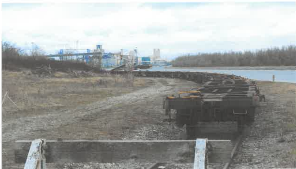
Vue sur l'embranchement ferroviaire existant
