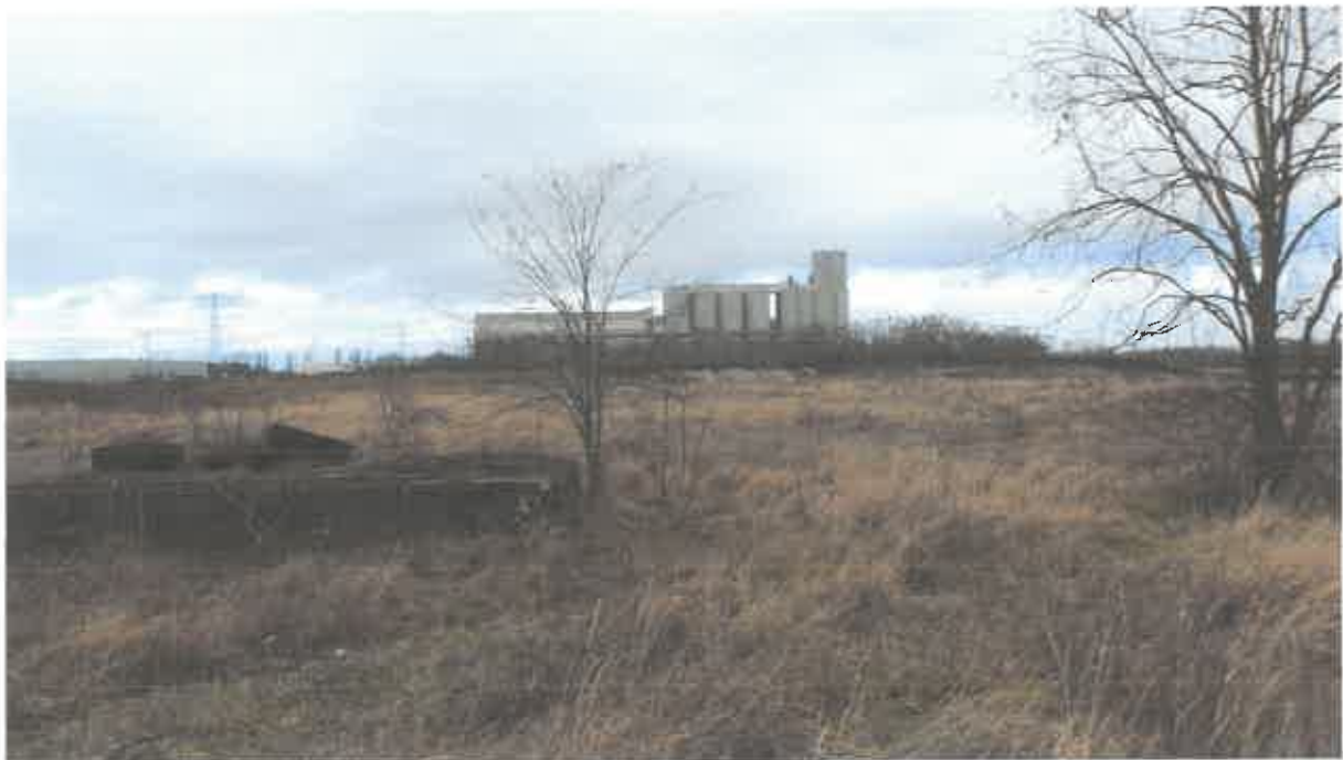
Vue depuis le Grand Canal d'Alsace
